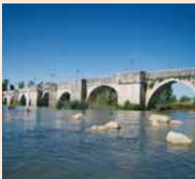
Puente de Simancas
