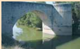
Puente en Puente Duero
